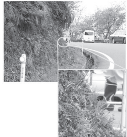
視距不良起点
