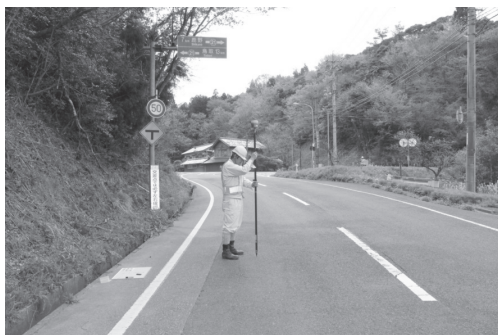
図-19 GNSS 測量を用いた座標の復元
