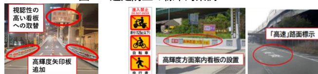
図-7 逆走防止の追加対策例
